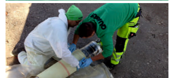
Einbau Kurzliner
