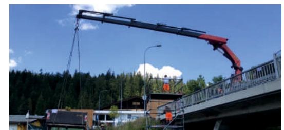
Vorbereitungsarbeiten für Inliner
