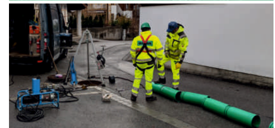
Kurzrohre beim Einbau in den Schacht
