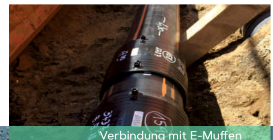
Verbindung mit E-Muffen
